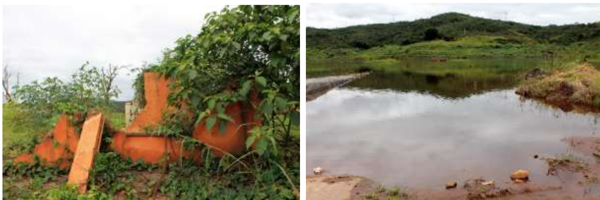
Imagens - À esquerda, vegetação crescendo sobre casa; à direita, alagamento causado pela construção do dique S4. Bento Rodrigues, 01/05/17. Fonte: Arquivo pessoal.
