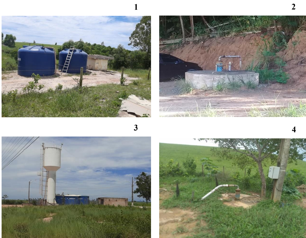
Figura 7 – Imagens dos poços subterrâneos e reservatórios utilizados para captar, armazenar e redistribuir água nas comunidades A e B (1), comunidade D (2) e comunidade C (3 e 4).
